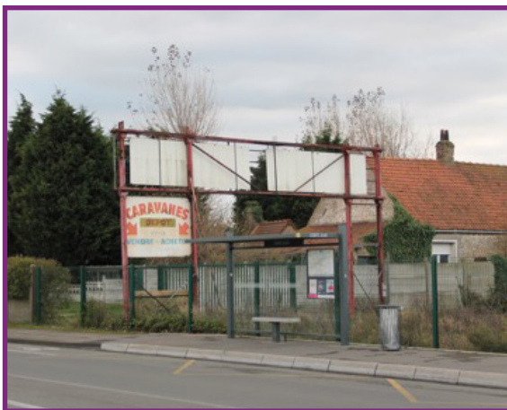
Des matériels dégradés
